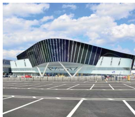
Конгресс-Холл, Екатеринбург-ЭКСПО, г. Екатеринбург
